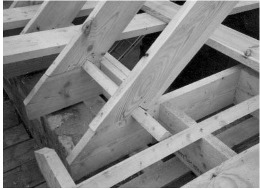
Fig. 6.36 Pole plate (1).
