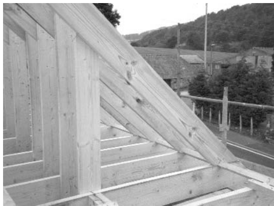
Fig. 6.37 Pole plate (2).
